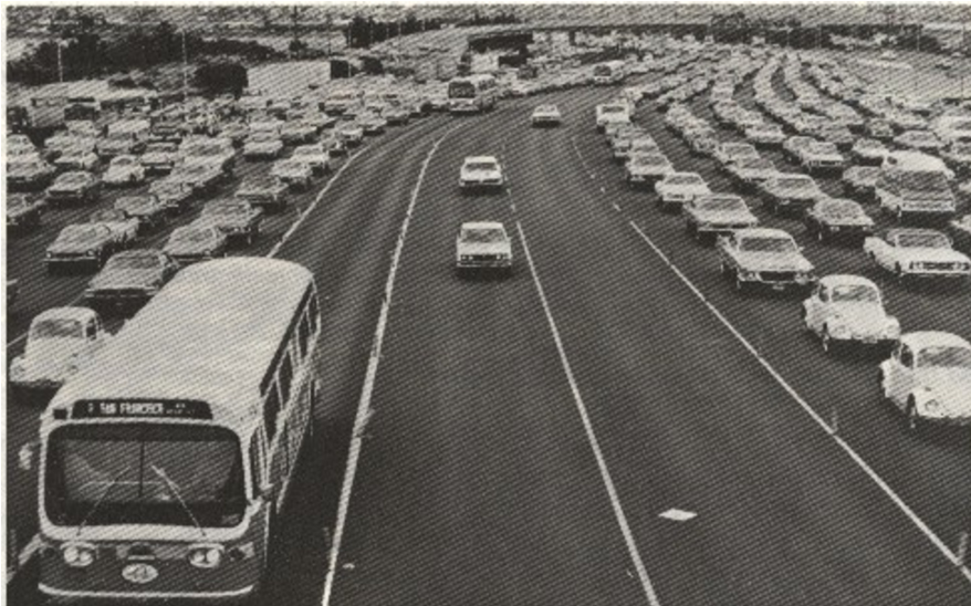
Слика 3.3 Засебна трака за ЈГП на истој коловозној површини и истом смеру (аутопут у Сан Франциску)
