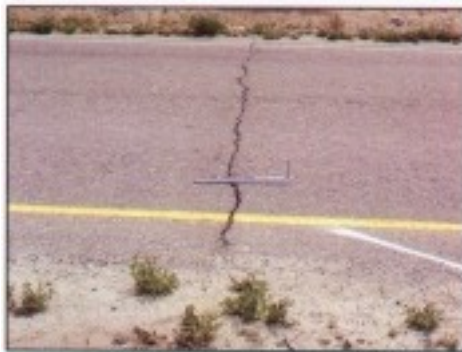
Слика 6.59. Велики ниво оштећености попречних пукотина
