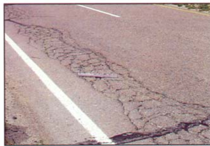
Слика 6.54. Велики ниво оштећености са пукотинама од замора
