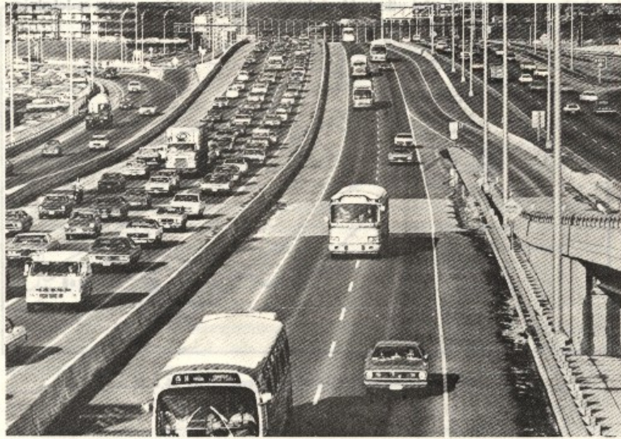
Слика 3.2 Физичко раздвајање јавног градског превоза - ЈГП (аутопут у Вашингтону)
