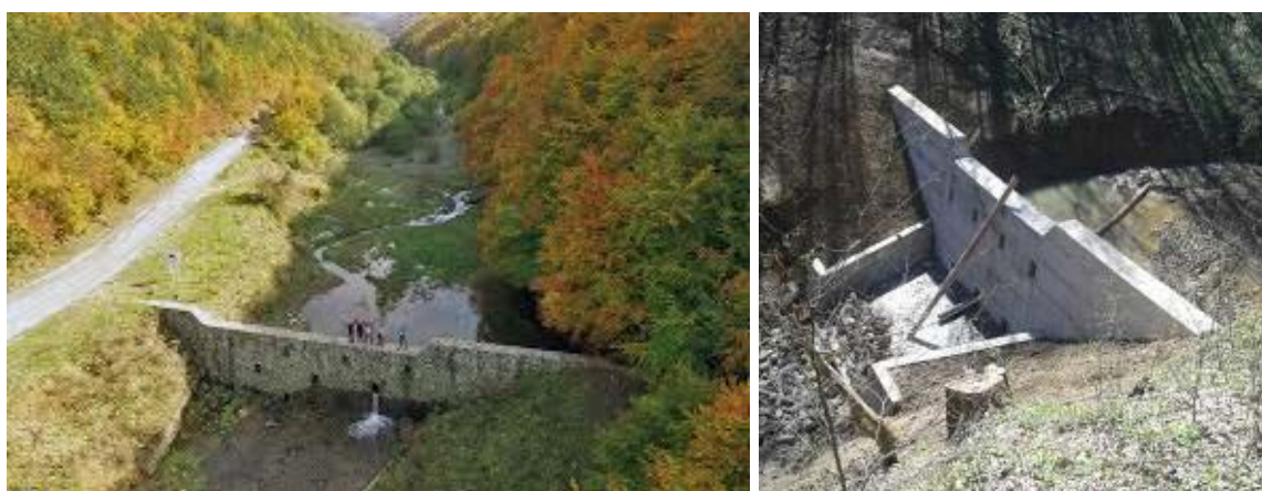
Слика 27 - Бујичне преграде од камена у цементном малтеру и од бетона
