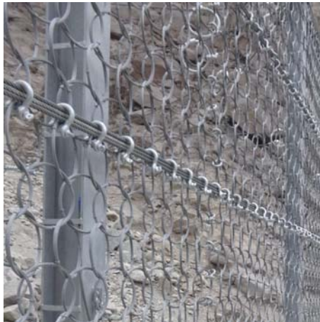
Слика 24 - Мрежа челичних прстенова (ROCCO ring net)
