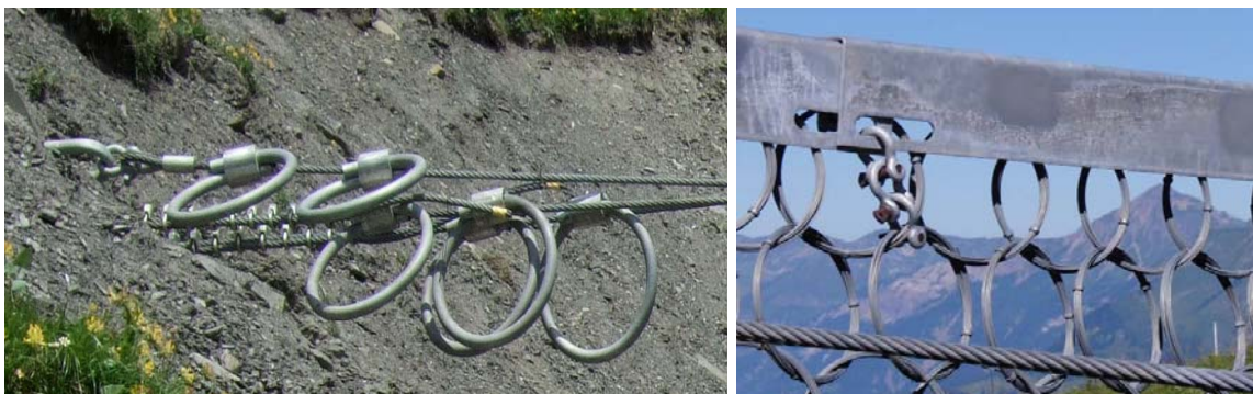
Слика 25 - Кочиони прстенови и заштитни L профили од челика
