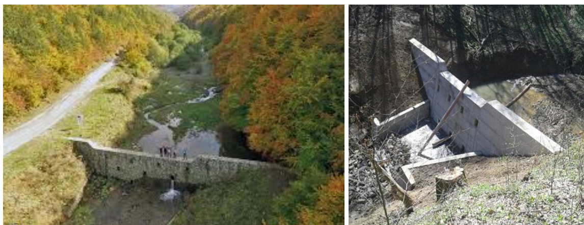
Слика 20 - Бујичне преграде од камена у цементном малтеру и од бетона
