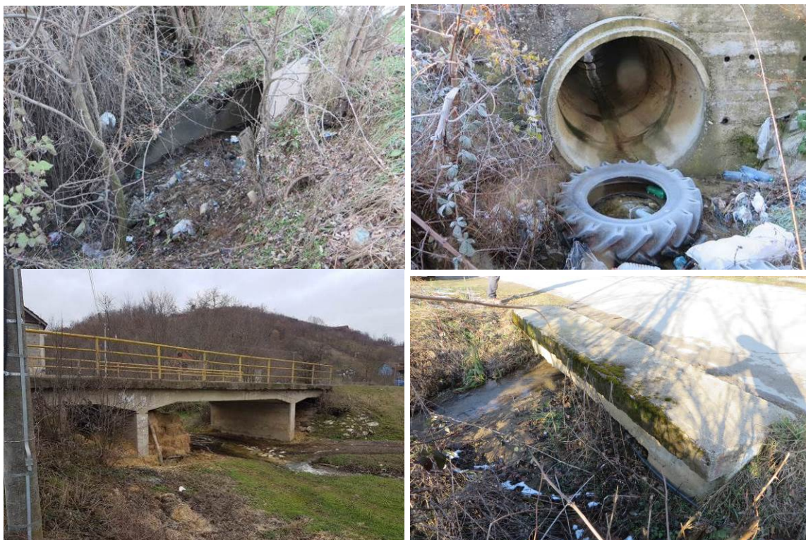
Слика 15 - Смањена пропусна моћ мостова и пропуста
