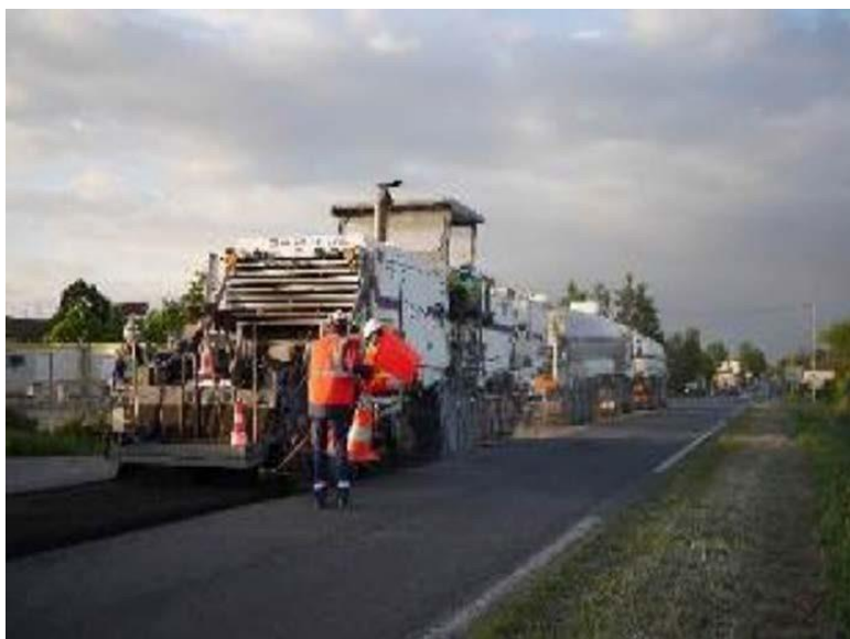
Слика бр. 4 - Техника хладног рециклирања (cold in – place recycling) - Француска 11
