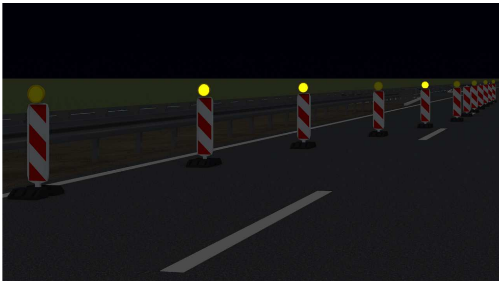
Слика 54. Погрешна употреба жутих светала упозорења СУ-1 у трепћућем режиму
