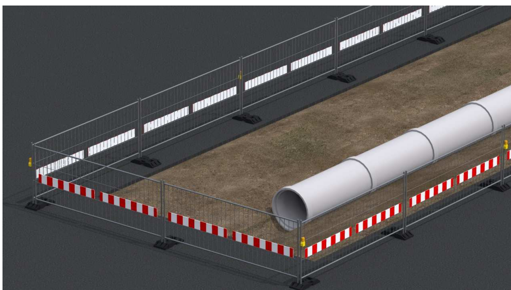
Слика 88. Ограђивање зоне радова монтажном жичаном оградом висине 1,8 m за дубине ископа преко 1,25 m
