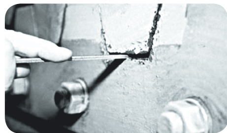
Сл. Мерење доњег зазора
