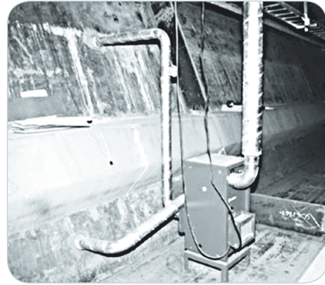
Сл. Апарат за смањење влаге унутар челичног сандучастог носача
