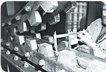
Сл. Мерење ширине шина за ваљак
