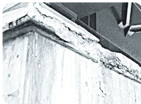
Сл. Разарање заштитног слоја лежишног квадера и чеоног зида
