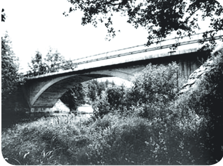
Сл. Бетонски лучни мост
