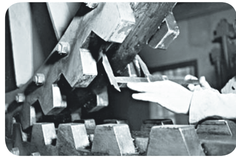
Сл. Мерење ширине котрљајућег сегмента
