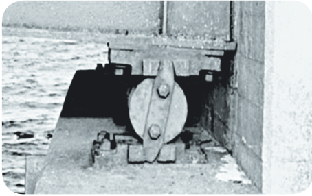
Сл. При додиру између носача и надзидка може доћи до деформација челичног носача
