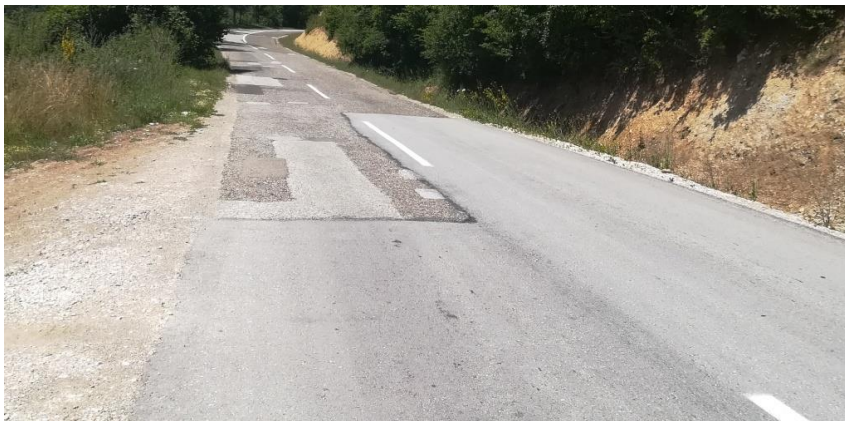
Слика 22. Пример поправке коловоза у мањим дужинама
