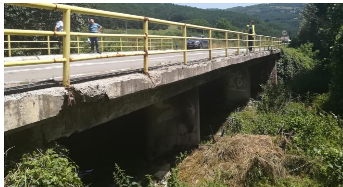
Слика 6: Мост на Љуцкој реци, km 86+265
