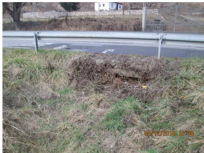
Слика 10. Плочасти пропуст на km 88+539.30
