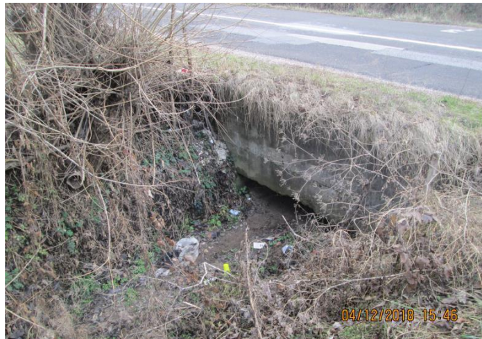
Слика 8. Плочасти пропуст на km 85+878.88 (Чебински поток)
