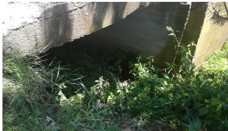
Слика 7. Плочасти пропуст на km 84+487.20 (Беловодски поток)
