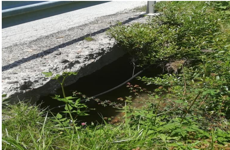
Слика 11. Плочасти пропуст на km 90+205.79 (Осаонички поток)
