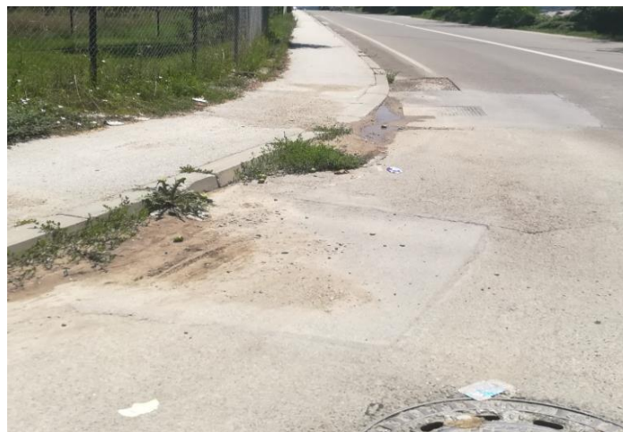
Слика 23. Постојећи "затворени" систем одводњавања
