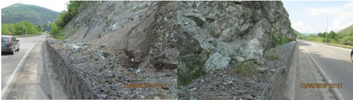
Слика 9. Габиони на предметној деоници
