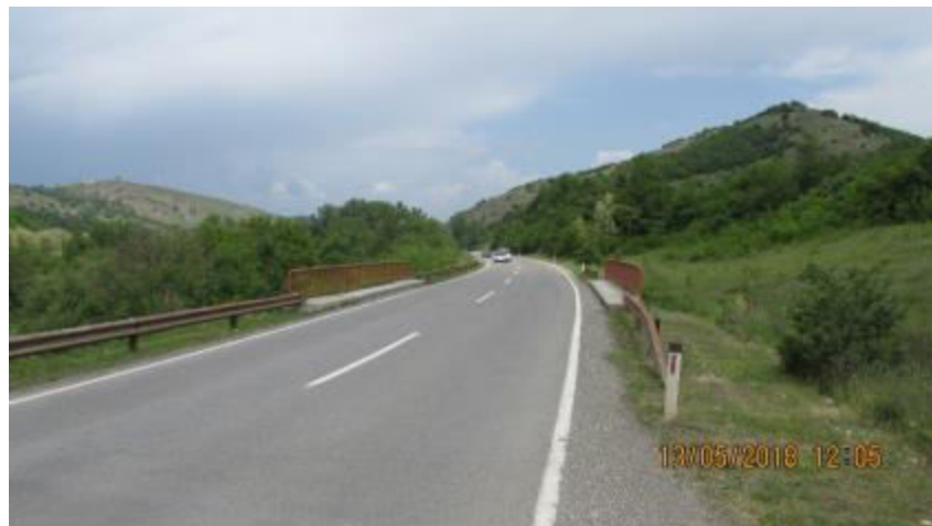
Слика 29. Мост преко локалног пута на км 244+058
