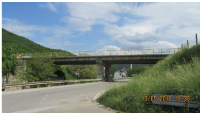
Слика 24. Мост преко Бањске реке и пута
