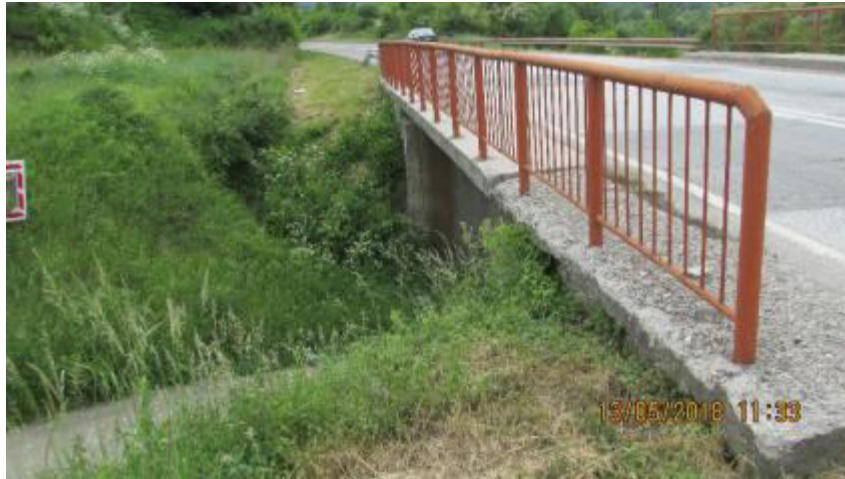
Слика 28. Мост преко локалног пута на км 241+323
