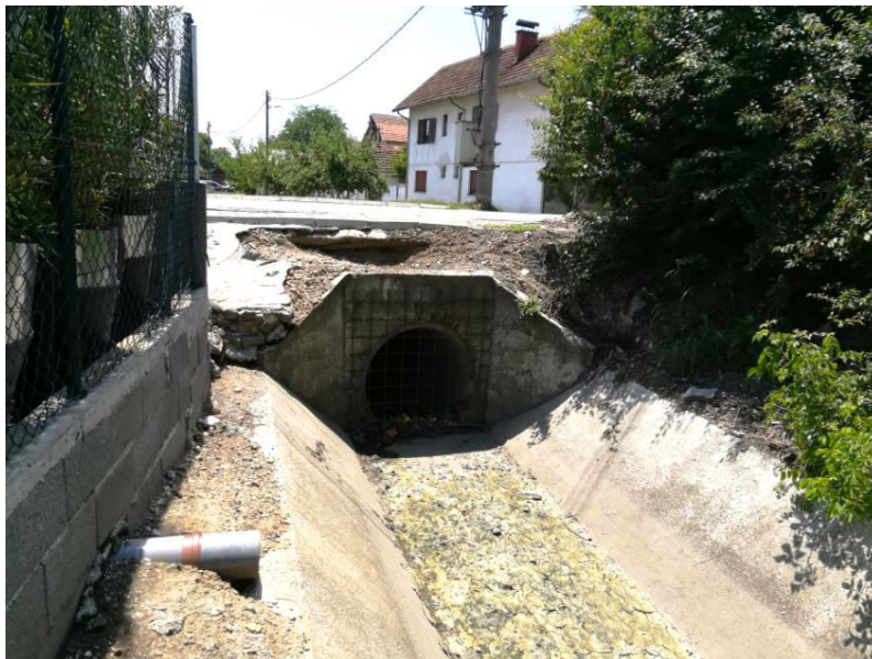
Слика 6. Неготин - попречно укрштање са бетонским каналом
