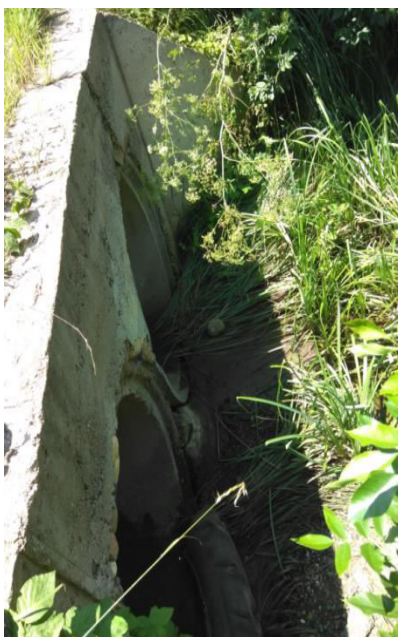
Слика 7. Пропуст \phi 1000 на км 190+106,43
