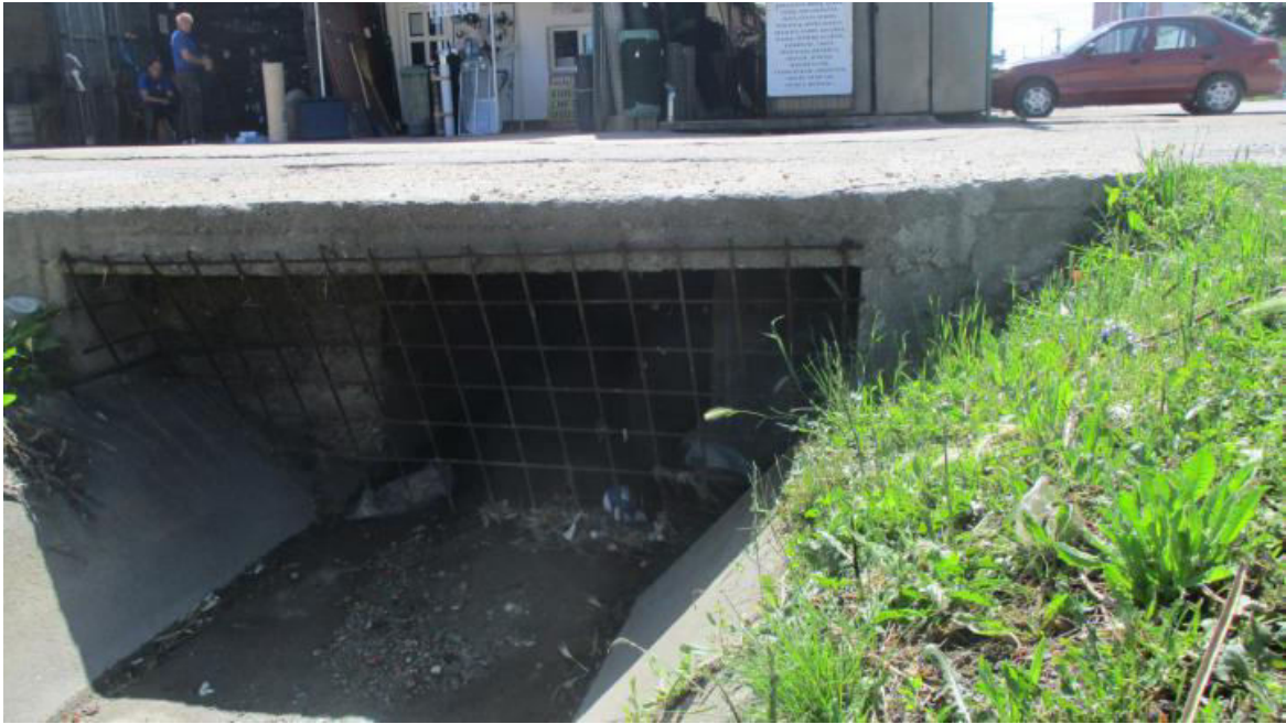
Слика 5. Неготин - прелазак у зацевљени део канала (Место где отвортени канал прелази у зацевљени канал)
