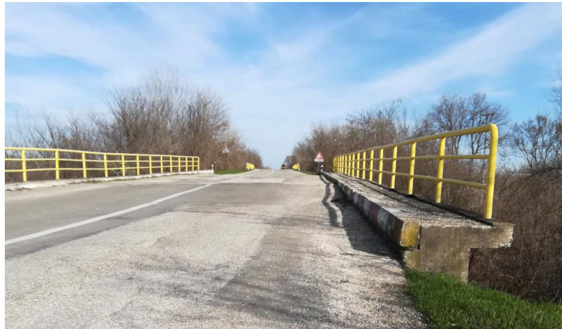
Слика 13. Мост преко Сиколске реке
