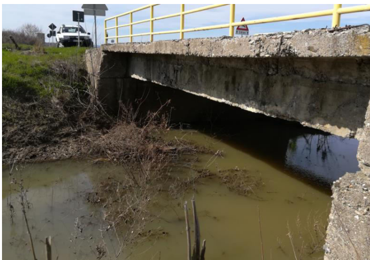
Слика 12. Пропуст преко канала "Сува препрека"
