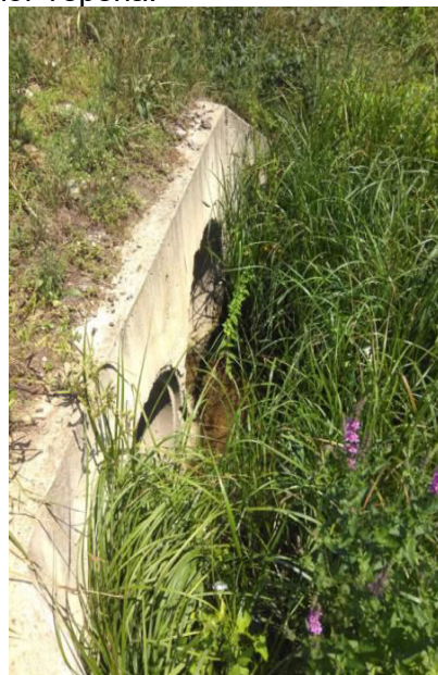
Слика 8. Пропуст \phi 1000 на км 190+106,43
