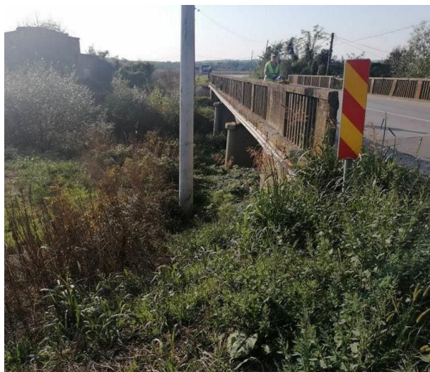
Слика 2-27 Мост преко реке Суви поток
