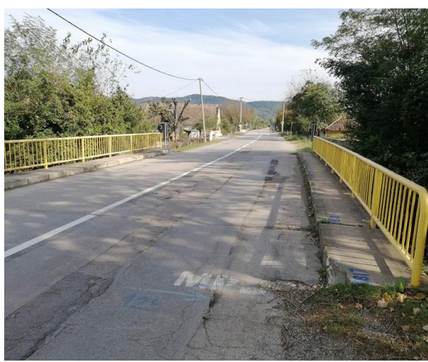
Слика 2-29 Мост у Мишљеновцу
