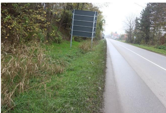
Слика 2-35 км ~20+000 јарак обрастао вегетацијом
