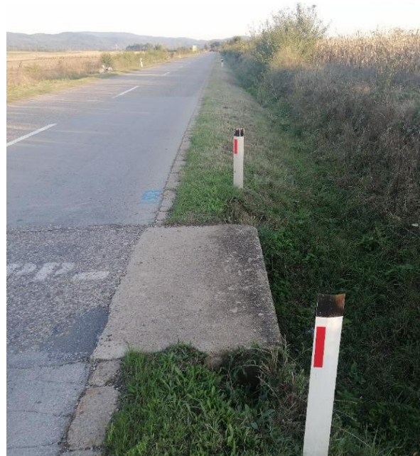
Слика 2-33 Плочаст пропуст и канал, на км 48+495
