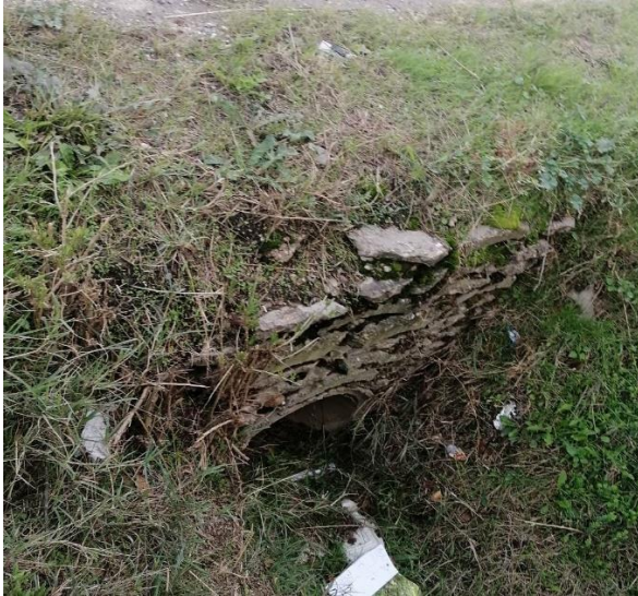
Слика 2-34 Засведен пропуст, на км 43+942
