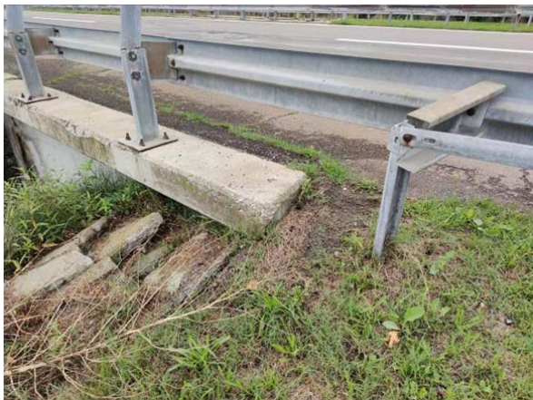
Слика бр.32: Неканалисан ток воде оштрђује плоче кегле
