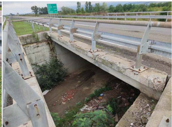
Слика бр.33: Изглед моста у разделном појасу
