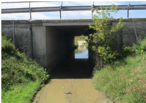
Слика бр. 26- Плочасти пролаз на км 451+737
