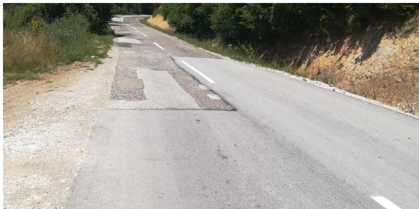
Слика 22. Пример поправке коловоза у мањим дужинама
