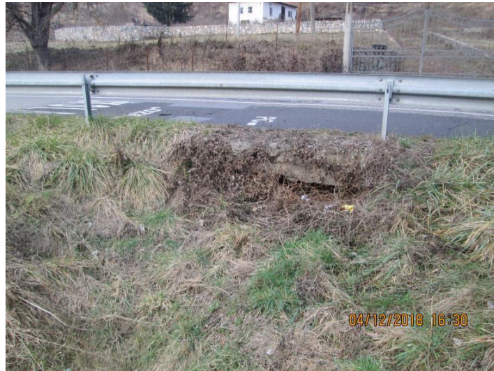
Слика 10. Плочасти пропуст на km 88+539.30
