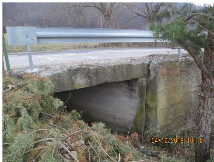
Слика 9. Плочасти пропуст на km 87+317.02 (Безимени поток Јанча)
