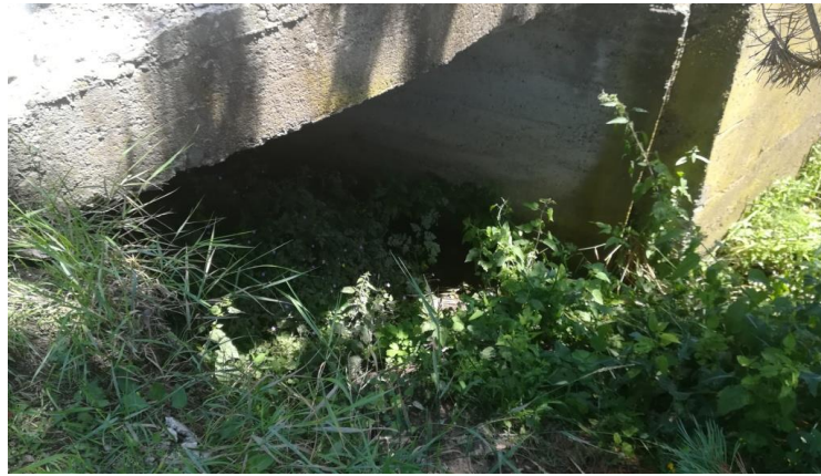
Слика 7. Плочасти пропуст на km 84+487.20 (Беловодски поток)
