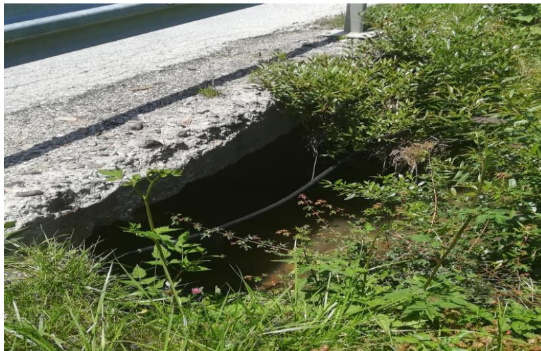
Слика 11. Плочасти пропуст на km 90+205.79 (Осаонички поток)
