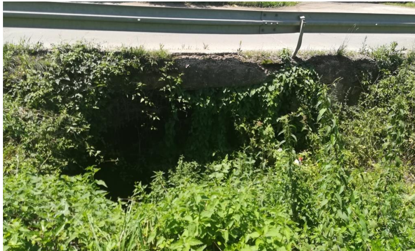
Слика 13. Плочаст пропуст, km 103+792.23, Реброњска река
