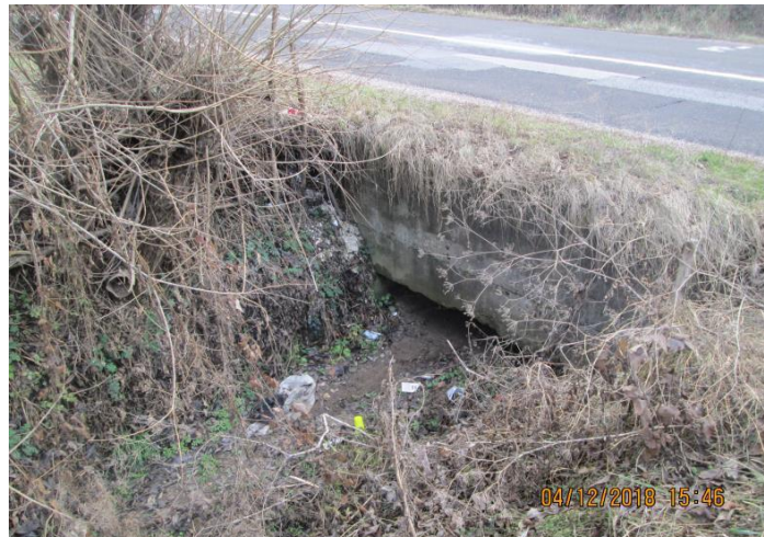
Слика 8. Плочасти пропуст на km 85+878.88 (Чебински поток)
