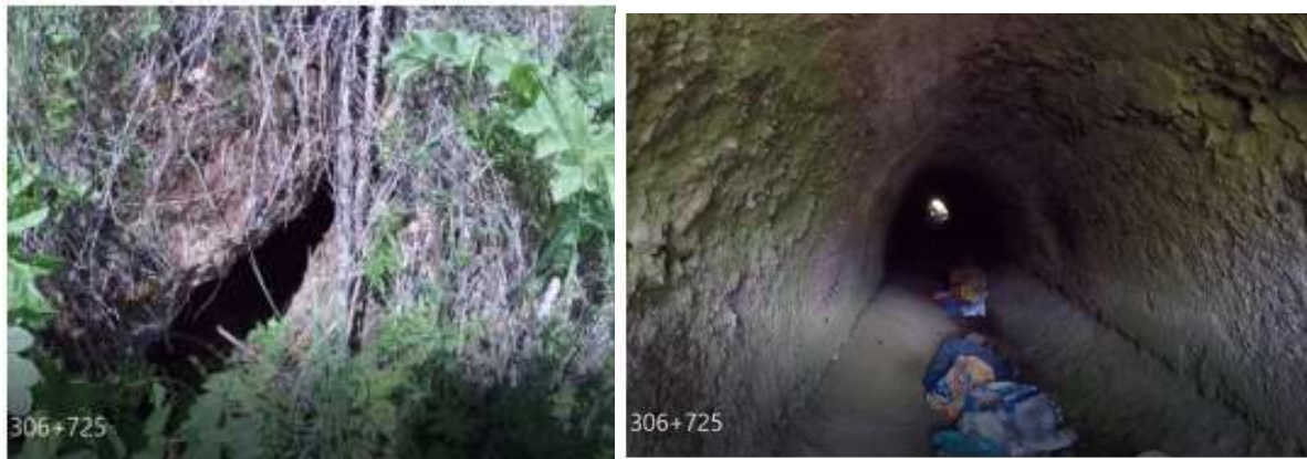
Слика 178. Засведен пропуст на км 306+725
