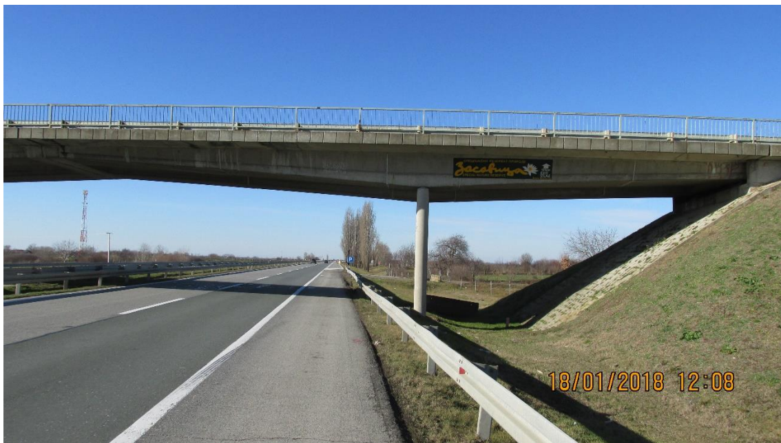
Слика 13. Надвожњак на км 52+684
