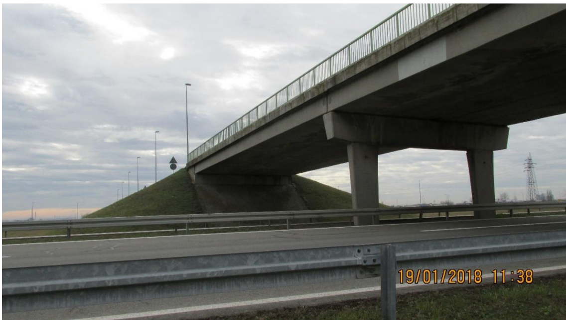
Слика 12. Надвожњак на км 44+200
