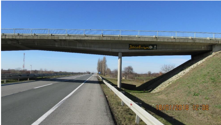
Слика 28. Надвожњак на км 52+684
