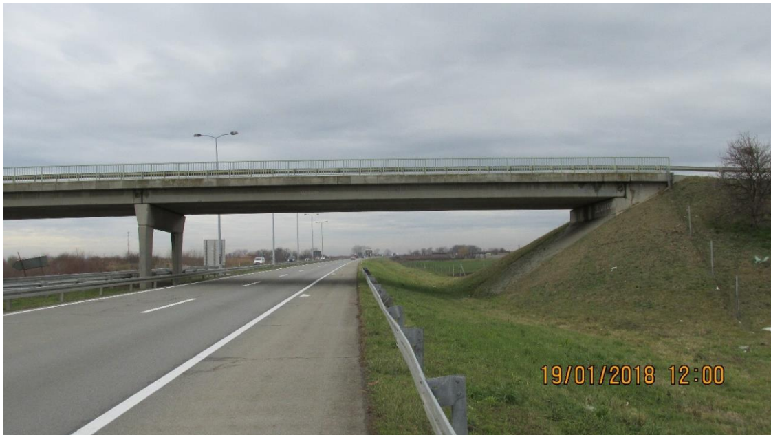
Слика 11. Надвожњак на км 43+550
