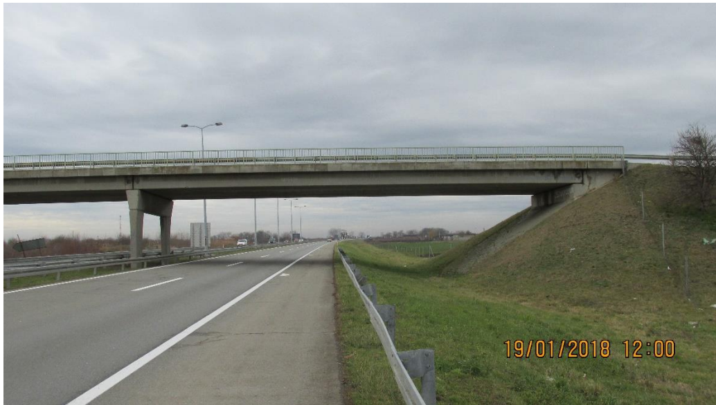
Слика 26. Надвожњак на км 43+550
