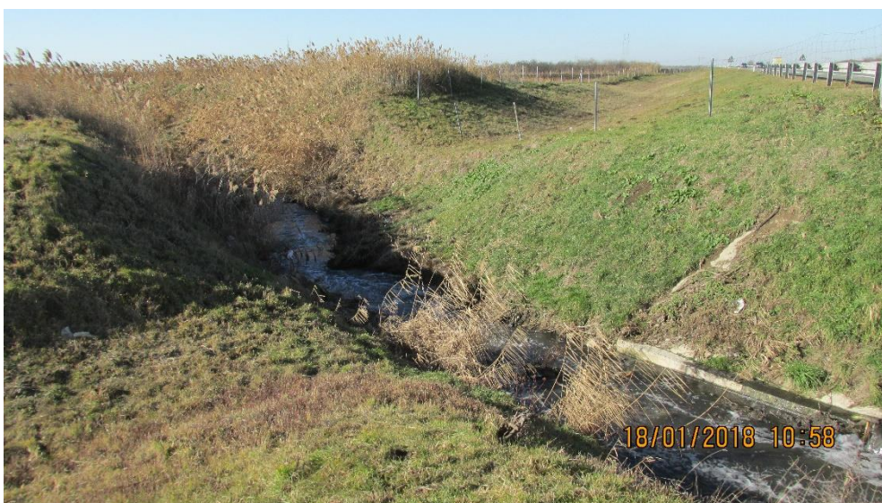
Слика 22. Канал Кудош на км 55+667
