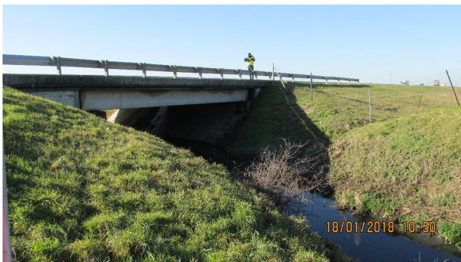
Слика 10. Канал Кудош на км 55+677
