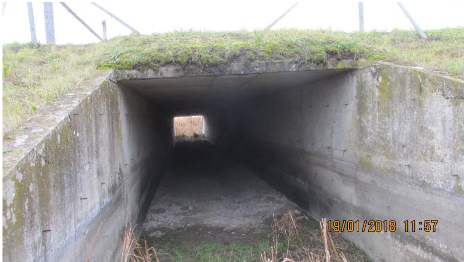
Слика 23. Плочасти пропуст на км 43+867
