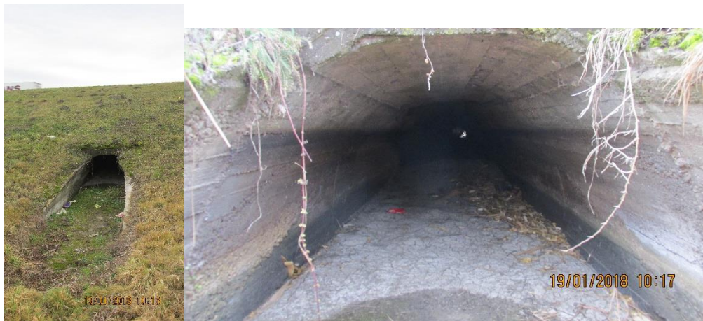
Слика 24. Засведени пропуст на км 47+874
