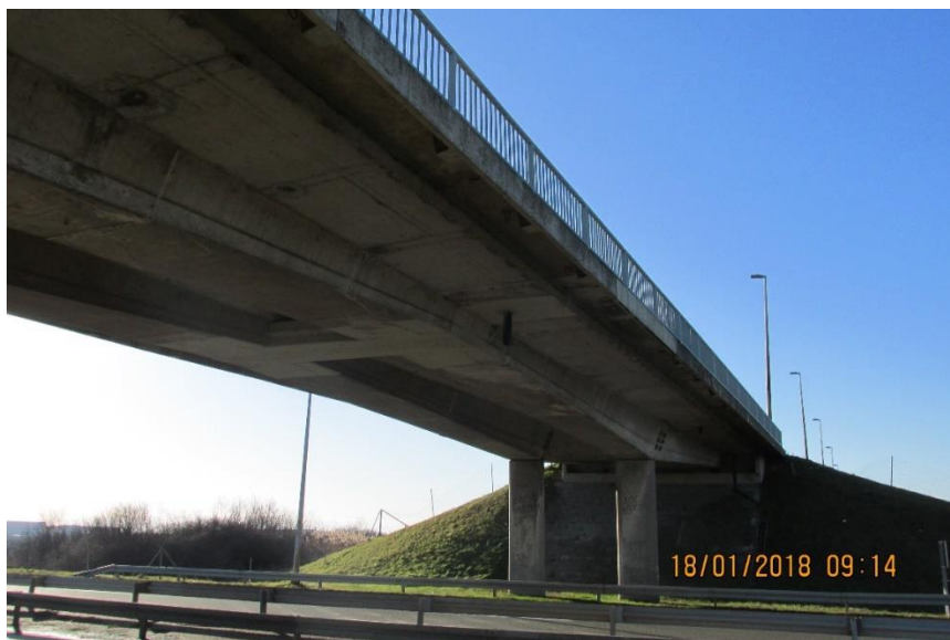
Слика 29. Надвожњак на км 57+313
