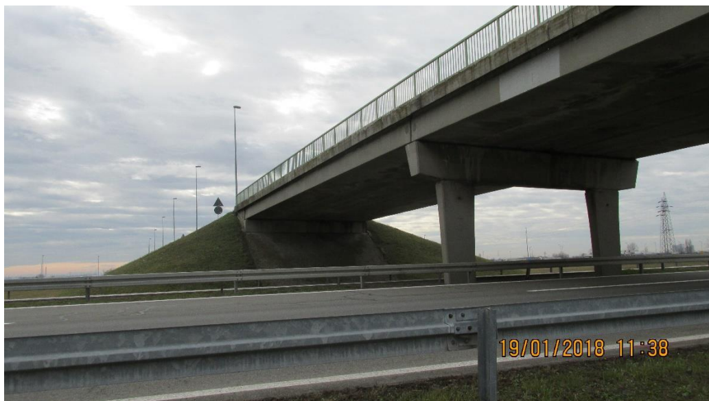
Слика 27. Надвожњак на км 44+220
