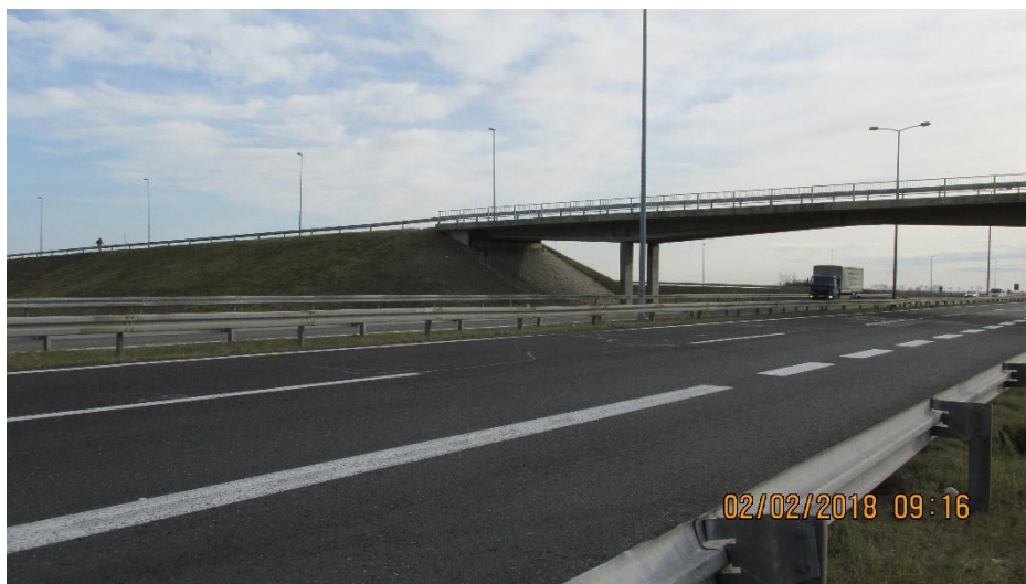
Слика 9. Надвожњак на км 57+850
