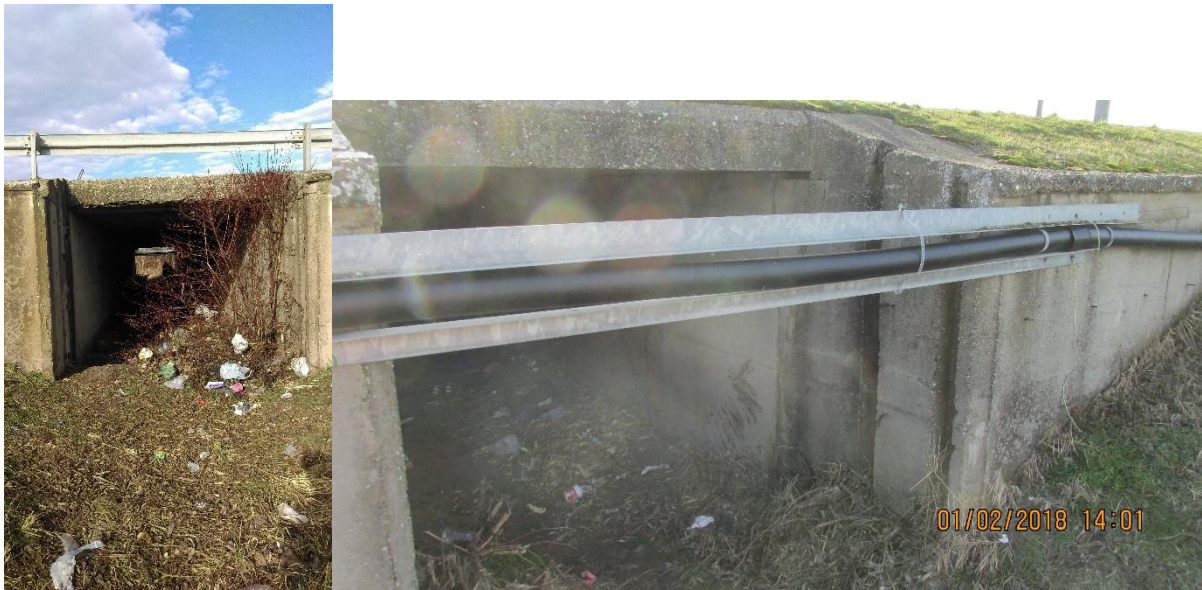
Слика 21. Плочасти пропуст на км 66+025
