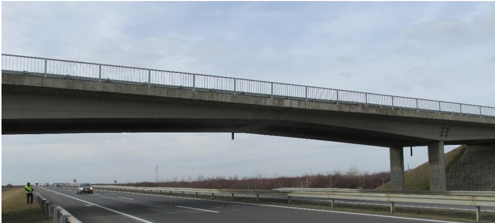
Слика 24. Надвожњак на км 65+320
