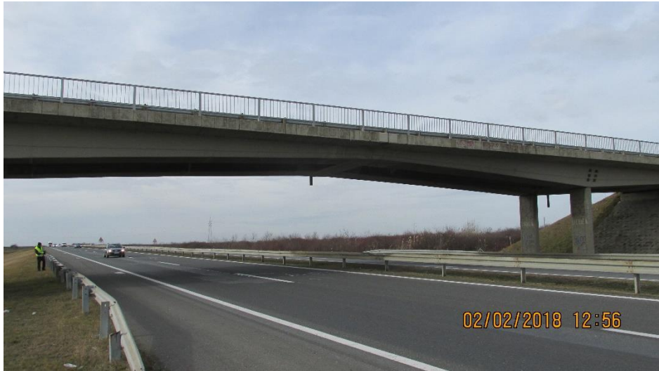
Слика 10. Надвожњак на км 65+320
