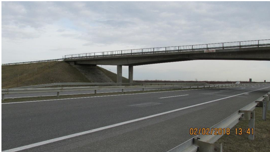
Слика 11. Надвожњак на км 68+200
