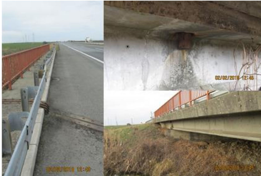
Слика 8. Мост преко канала Јарчина на км 65+040.00
