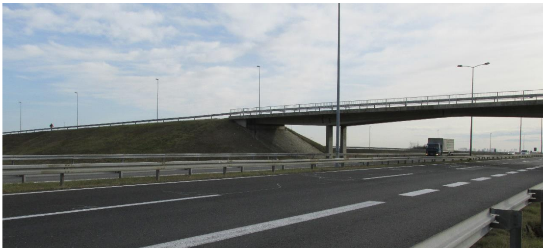
Слика 23. Надвожњак на км 57+850
