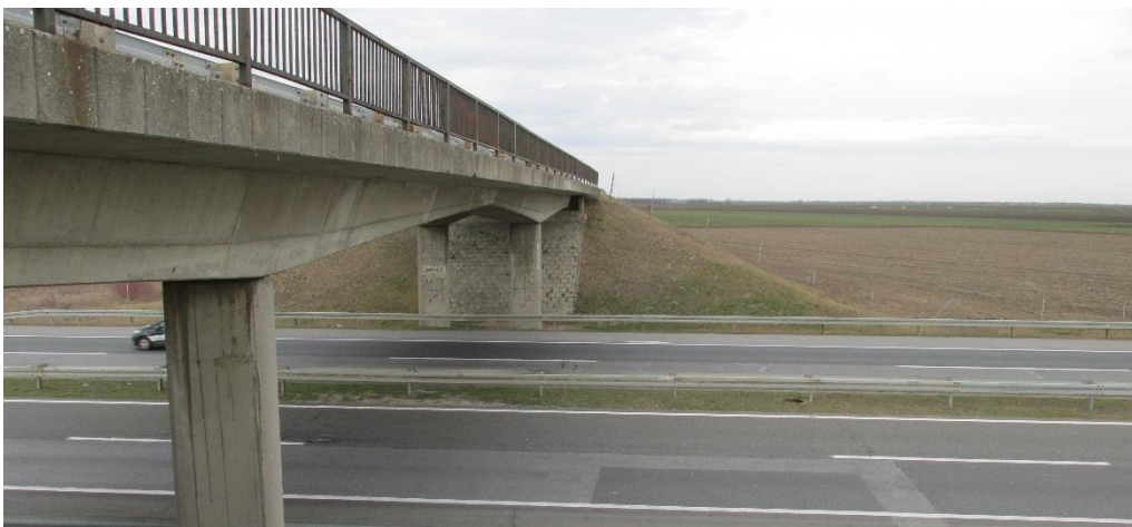
Слика 25. Надвожњак на км 68+200
