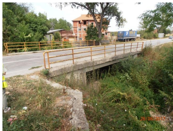
Слика 3.14 - Мост преко Југбогдановачке реке
