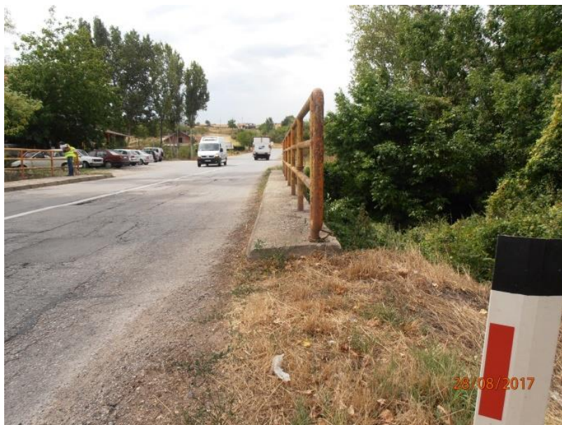
Слика 1.6 - мост преко Југбогдановачке реке
