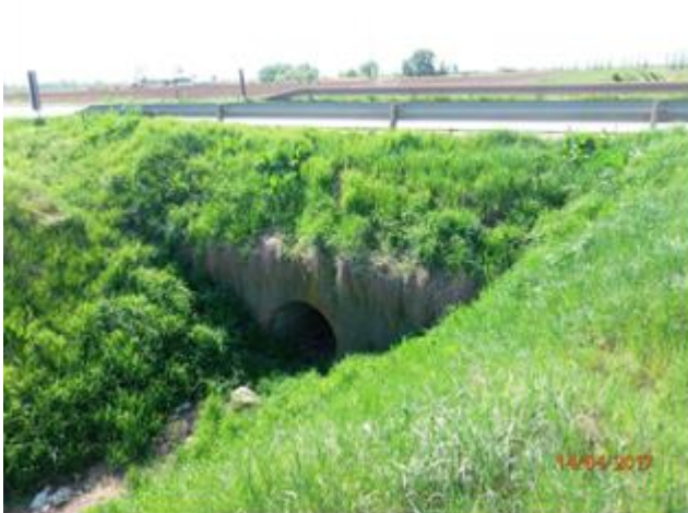
Слика 4 Укрштање канала и пута на стационажи пута км 82+475.
