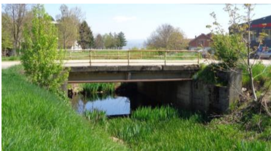
Слика 17. Мост преко потока
