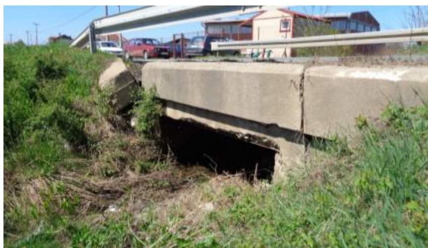
Слика 18. Плочасти пропуст за повремени бујични водоток
