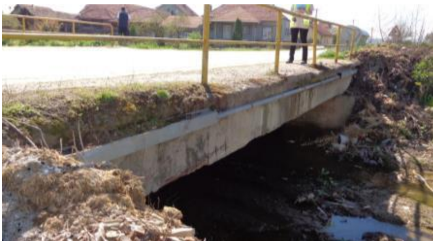
Слика 16. Мост преко Туловске реке
