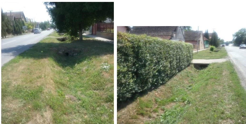
Слика 3 Постојећи отворени канали који гравитирају Великом каналу
