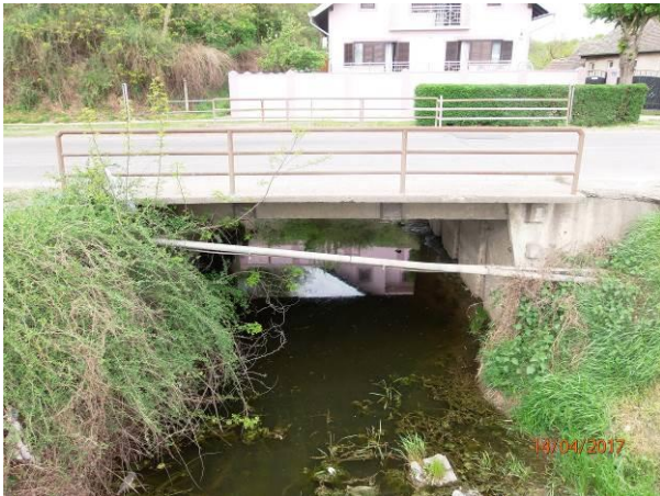
Слика 4 Постојећи мост на стационажи пута km\ 63+735
