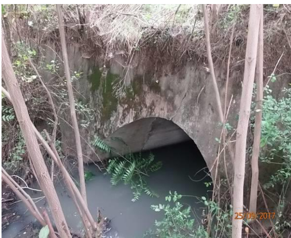
Слика 6 засведен пропуст на km\ 67+845
