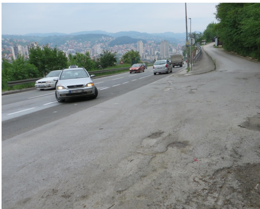
Слика 6. Локација раскрснице са улицом Љубице Чакаревић - конфликт траке за лево скретање и претицајне траке
