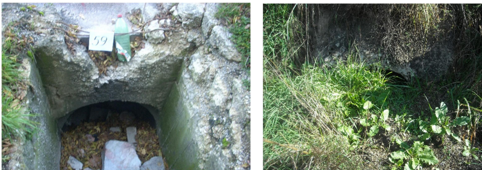
Слика 12: Пример смањења пропусне моћи пропуста и потребе за санацијом
