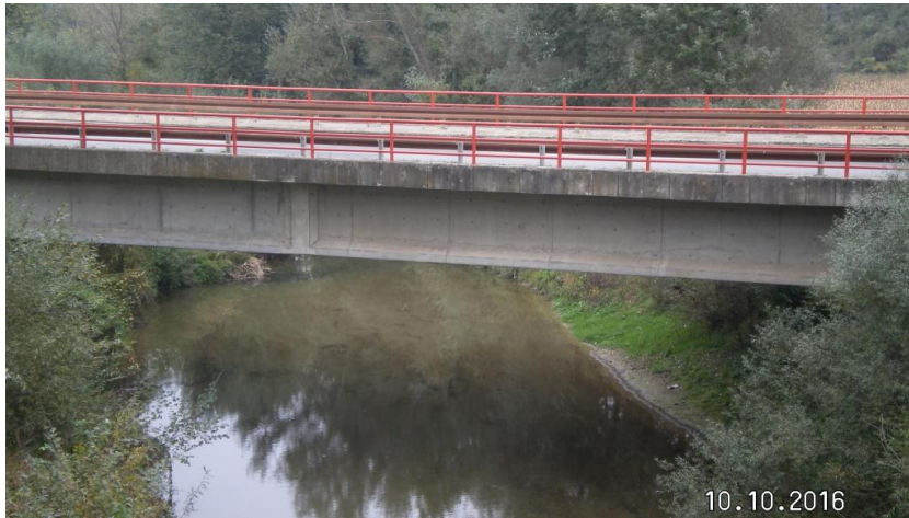
Слика 10. Мост на реци Јасеници
