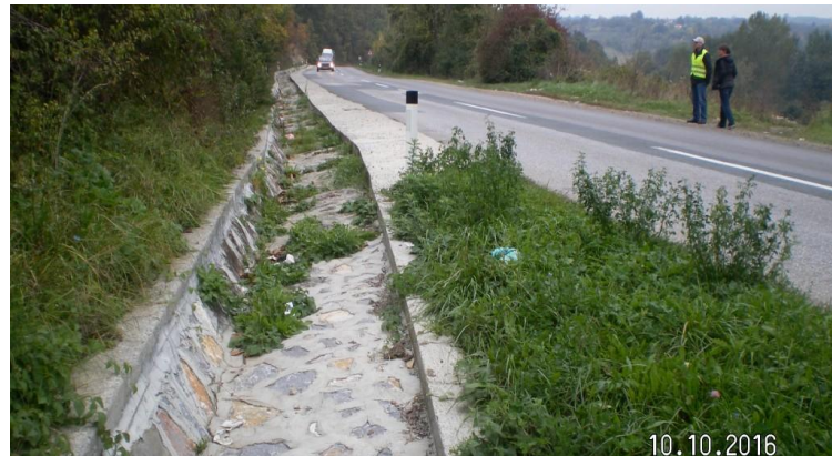
Слика 20. Постојећи канал за одводњавање - Божурња
