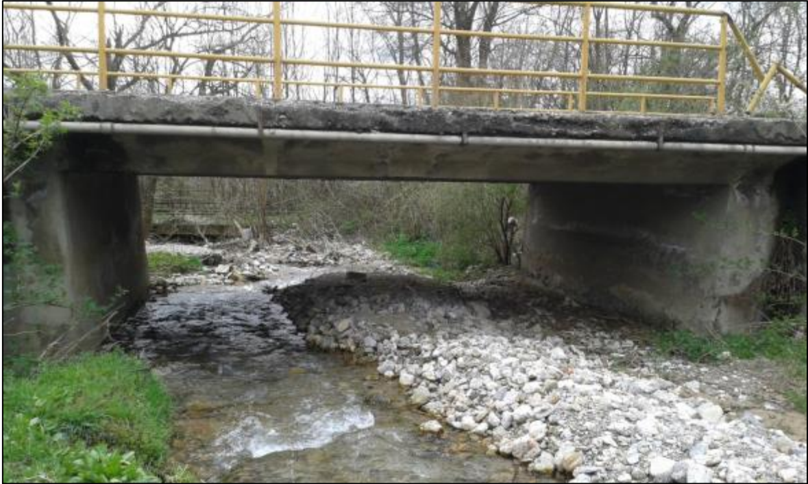
Слика 6. Мост преко Гавриног потока ~ km 6 + 100
