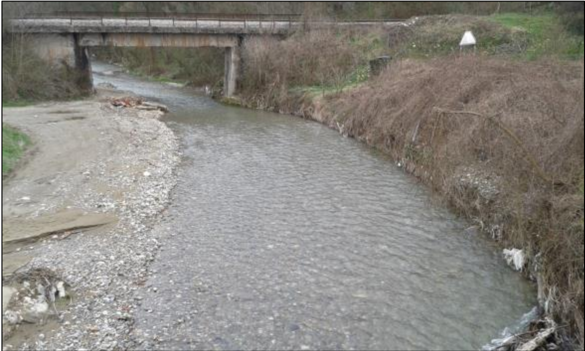
Слика 8. Мост преко Боринске реке ~ km 9 + 130
