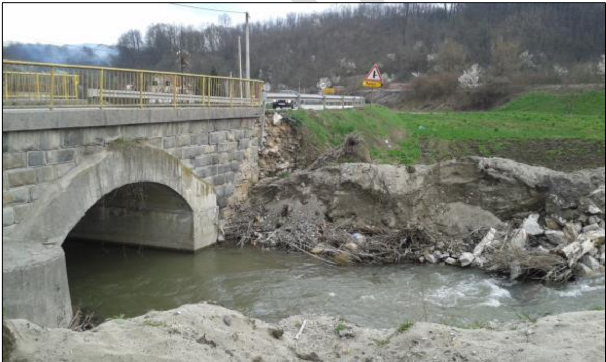
Слика 9. Мост преко Радаљске реке ~ km 12 + 265
