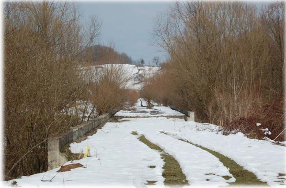
Слика 14. Пруга у изградњи, непосредно поред пута
