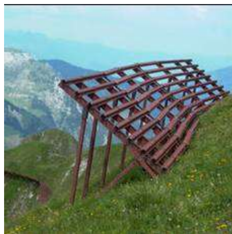
Slika 7.3.2.6: Snežne grablje za podupiranje snežnog pokrivača na strmoj padini
