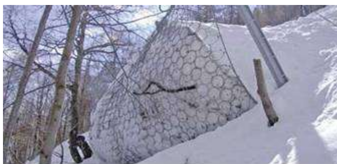
Slika 7.3.2.5: Snežne mreže za podupiranje snežnog pokrivača na padini
