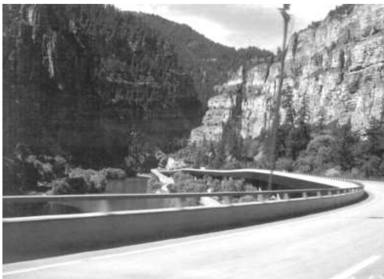
Slika 4.2.45: Neestetsko vitoperenje na dugačkom vijaduktu
