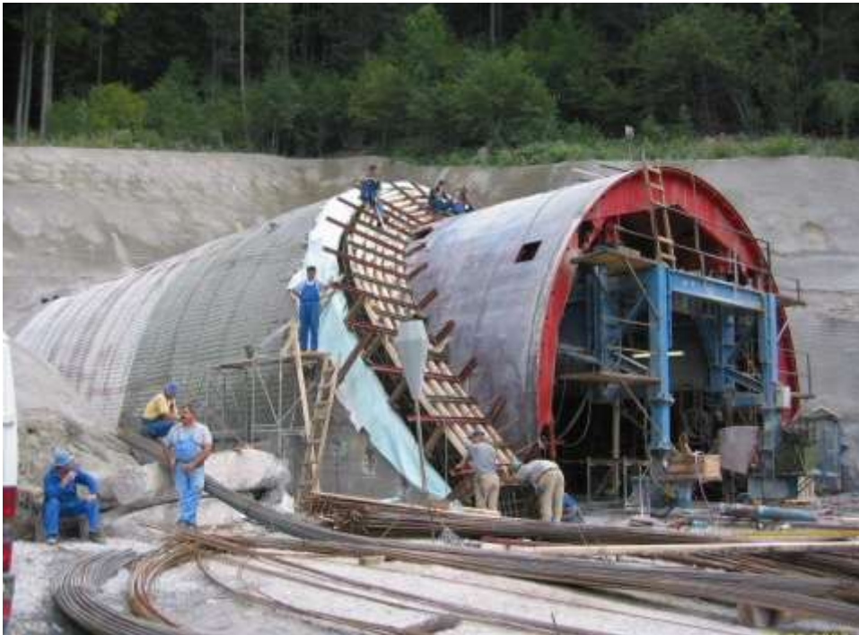
Slika 11.3.13: Portal tunela; izvođenje „cut and cover“ - pokrivenog usjeka
